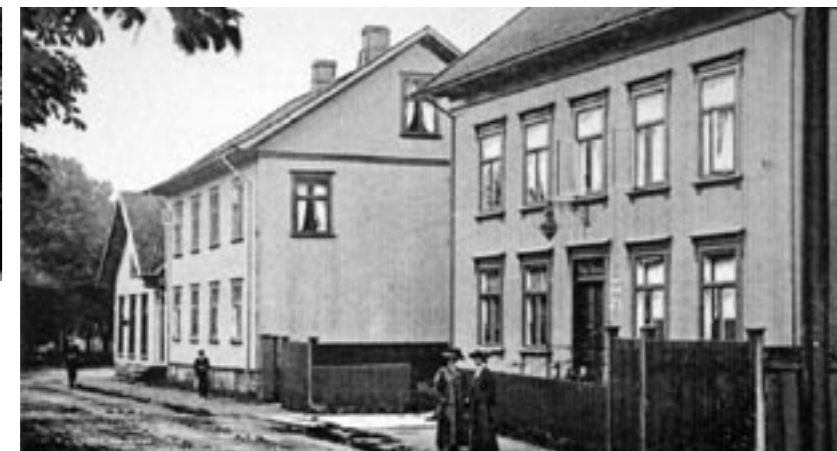
OLLEBAKKEN MOT BEKKEGATEN. Huset nærmest er Hortens Sparebank, senere Sjømenns Leseværelse. Det neste huset var kjøpmann Becks privatbolig. Huset på hjørnet med gavlen mot gaten var Becks, og senere mange andres, butikk. (LA6117)
