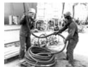
Klar til trekk av landtilkoblingskabel - Oddvar Been og Arild Stene Elektrisk verksted (avd. 40)
